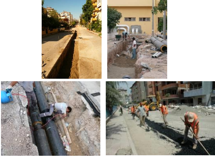
Şekil 8.15. Kanalların Kazılması, Boruların Döşenmesi ve Montajı
