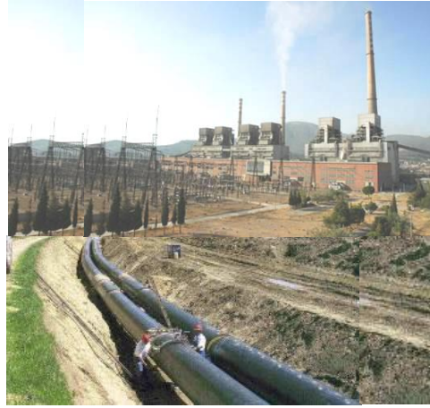
Şekil 8.14. Örnek bir bölgesel ısıtma sistemi boru hattı
